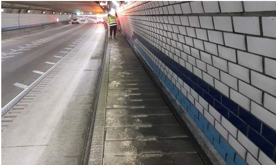
NATM구간 공동구 전경
