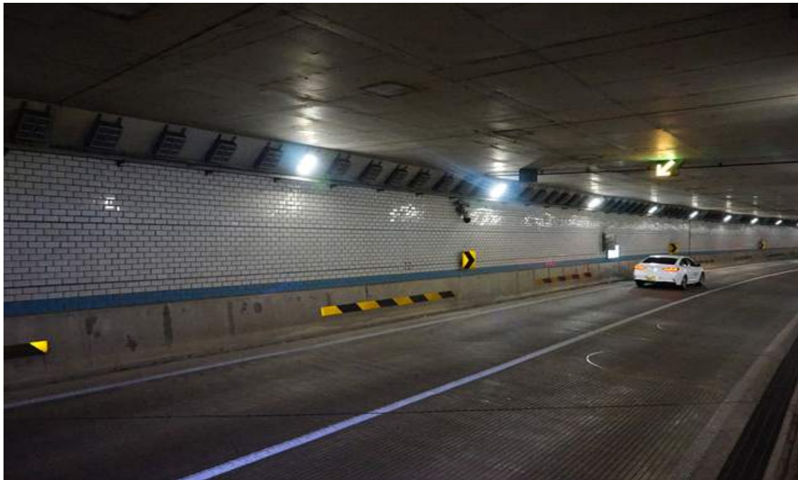
BOX구간 벽체 전경
